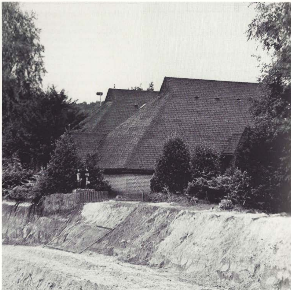
Het Scoutinggebouw aan de Smaldonkstraat is momenteel wat moeilijker bereikbaar vanwege de aanleg van een bergbezinkbassin
